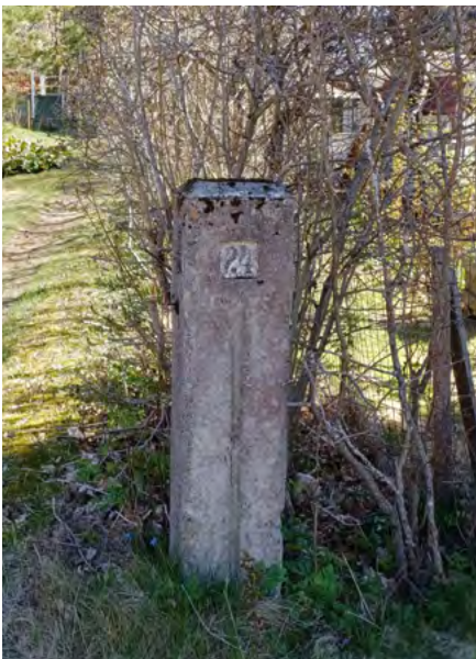
Tyypillisesti piha-alueita ovat rajoittaneet kadun puolelta metalliset portit, jotka on kiinnitetty betoni-paasiin. Näiden vierestä on lähtenyt orapihlaja- tai muu pensasaita kiertämään tonttia. Tässä Pihlajakadulla alkuperäinen kiinteistö-numerolla varustettu portinpieli.
