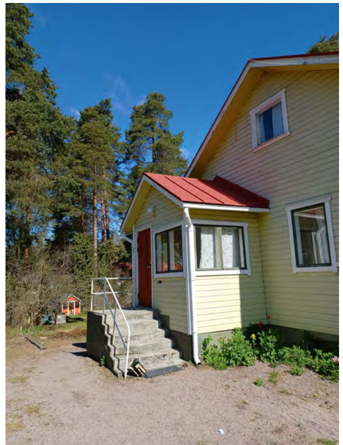
(yläpuolella) Kuisti portaikkoinen on al- kuperäistä vastaavassa asussa.
