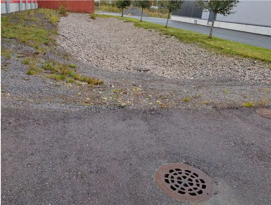
Kuva 8. Motonetin ja Prisman välissä oleva hulevesien viivytys.
