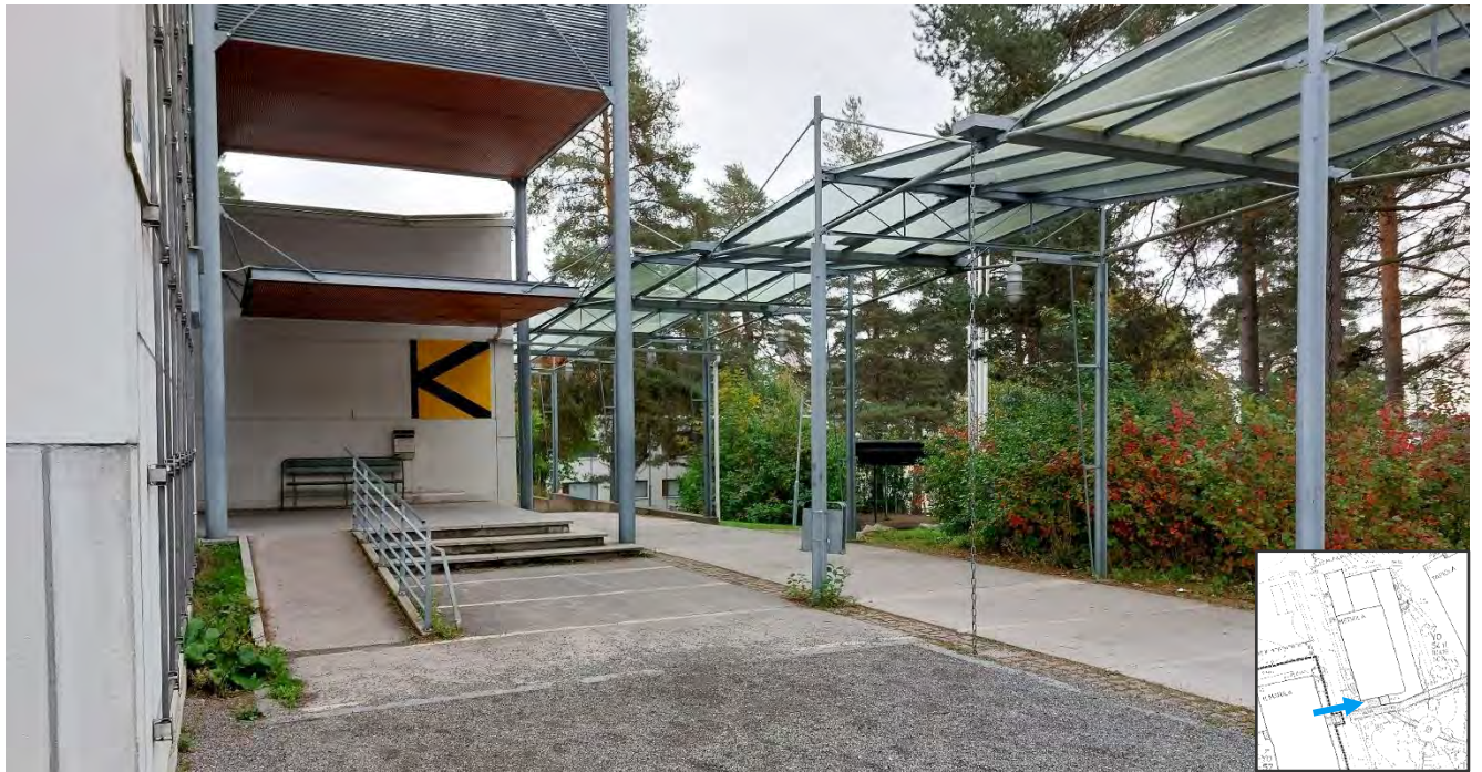
Kuva 93. Metsolan pääsisäänkäyntiä korostavat teräs-puupaneli-katos ja suuri opaste.
