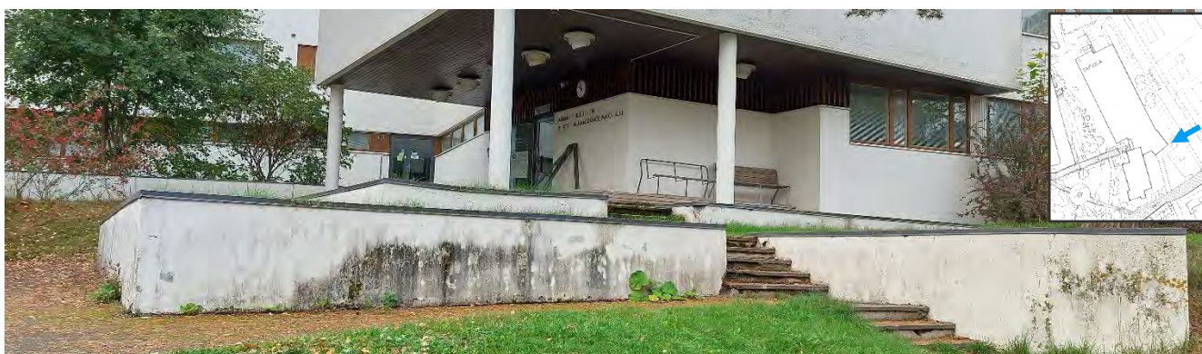
Kuva 62. Betonisilla tukimuureilla on muotoiltu rinteistä piha-aluetta.
