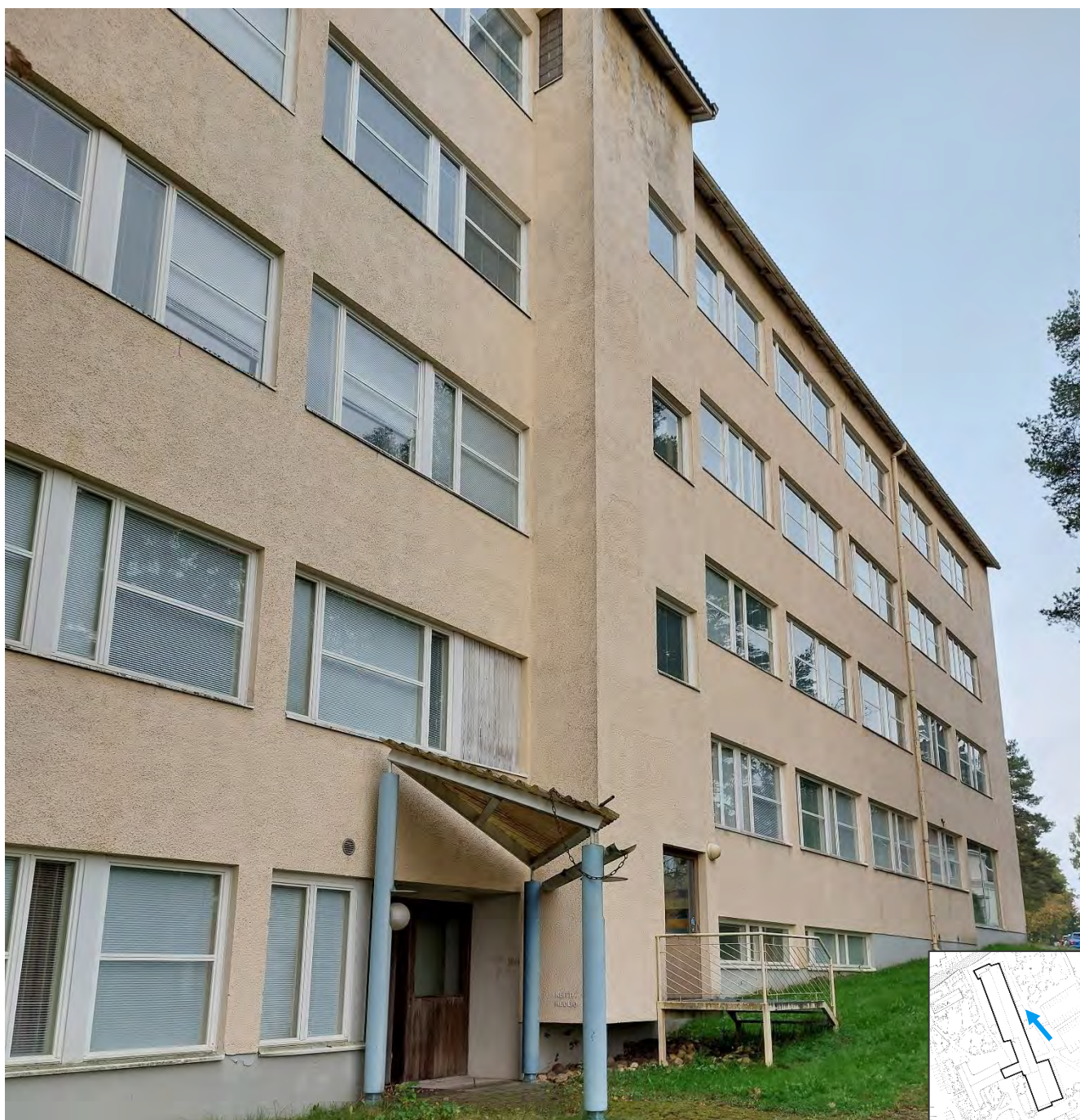
Kuva 36. Seinälinjasta ulkonevan porrastornin alaosa on sisäänkäynti suoraan porraskäytävään. Sen vieressä on tavarahissin eteisen ulko-ovi.
