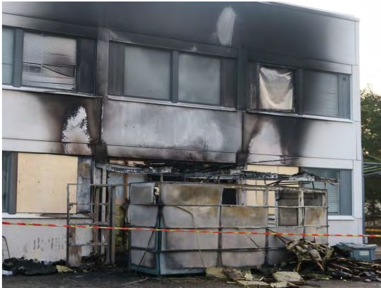
Kuva 92. Vasemmalla Metsolan pahoin vaurioitunut keittiösiipi ulkojäteastiasta lähteneen tulipalon levittyä sisätiloihin uudenvuoden aattona 2019 (Lähde: Yle uutiset). Oikealla uusi huoltokatos syyskuussa 2023.
