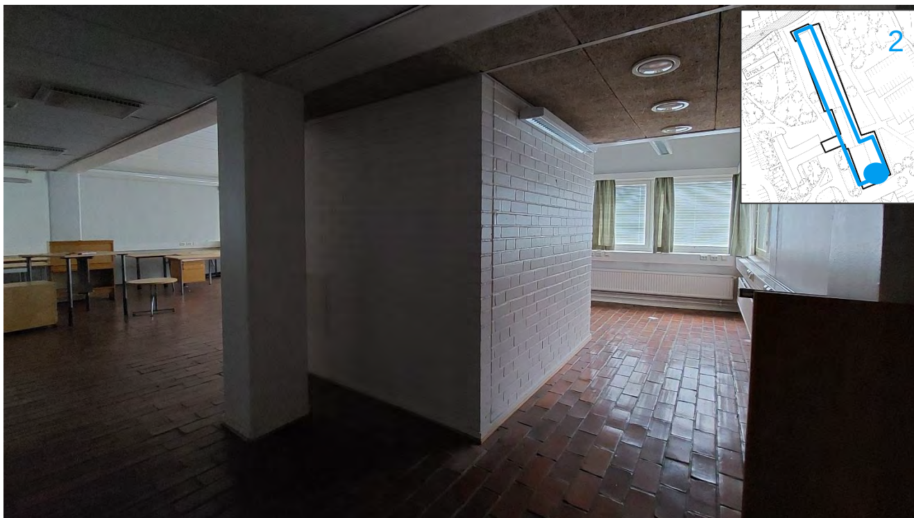
Kuva 39. Kirjaston yksikerroksisessa siipiosassa on lattiamateriaalina tiili, kuten ensimmäisessä kerroksessa. Tilan keskellä kulkevat hormit.
