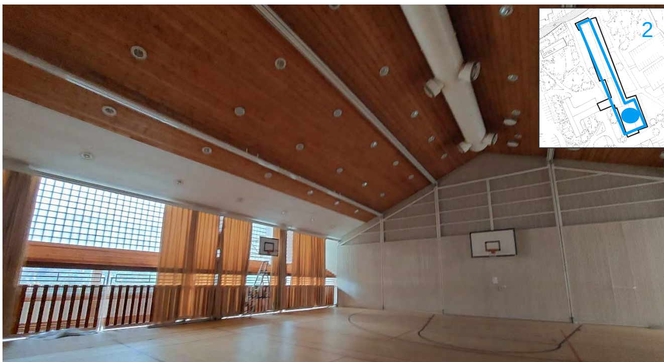
Kuva 42. Liikuntasalissa on osittain lasitiiliset ulkoseinät ja puupaneloitu sisäkatto.
