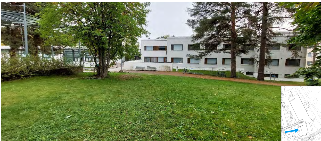
Kuva 68. Kolmikerroksinen asuntolasiiven länsijulkisivu aukeaa kampusalueen oleskelupihalle.
