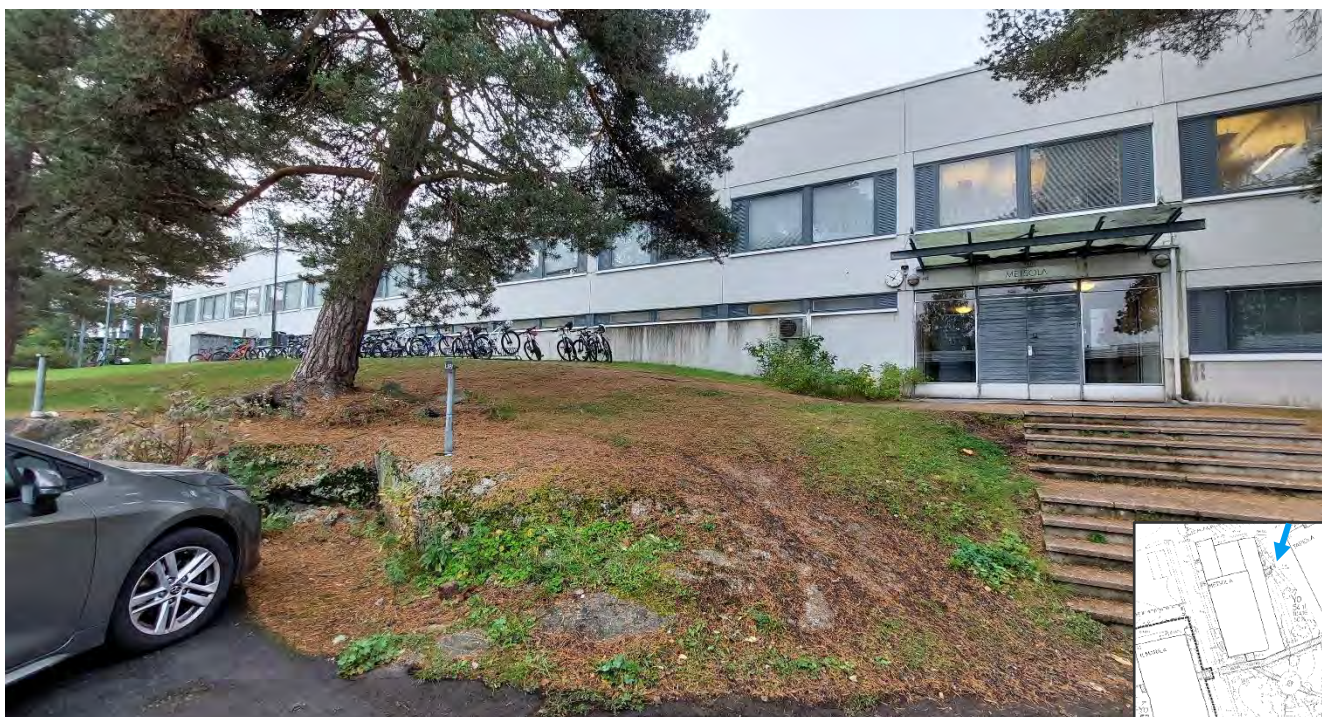
Kuva 97. Pohjakerroksen sisäänkäynti johtaa parkkialueelta pukuhuoneisiin ja auditoriotiloihin.
