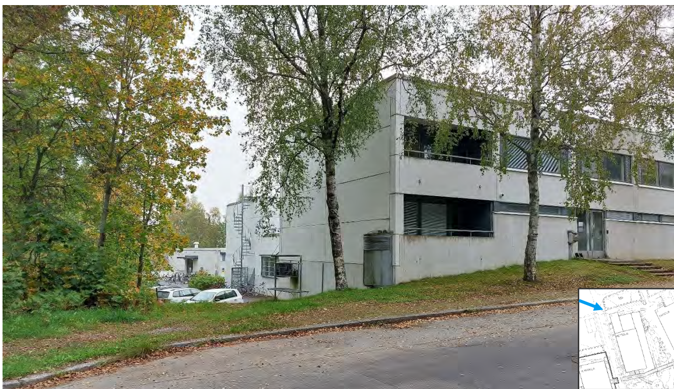
Kuva 99. Rakennusten pohjoisseinät ovat pääasiassa ikkunattomat.
