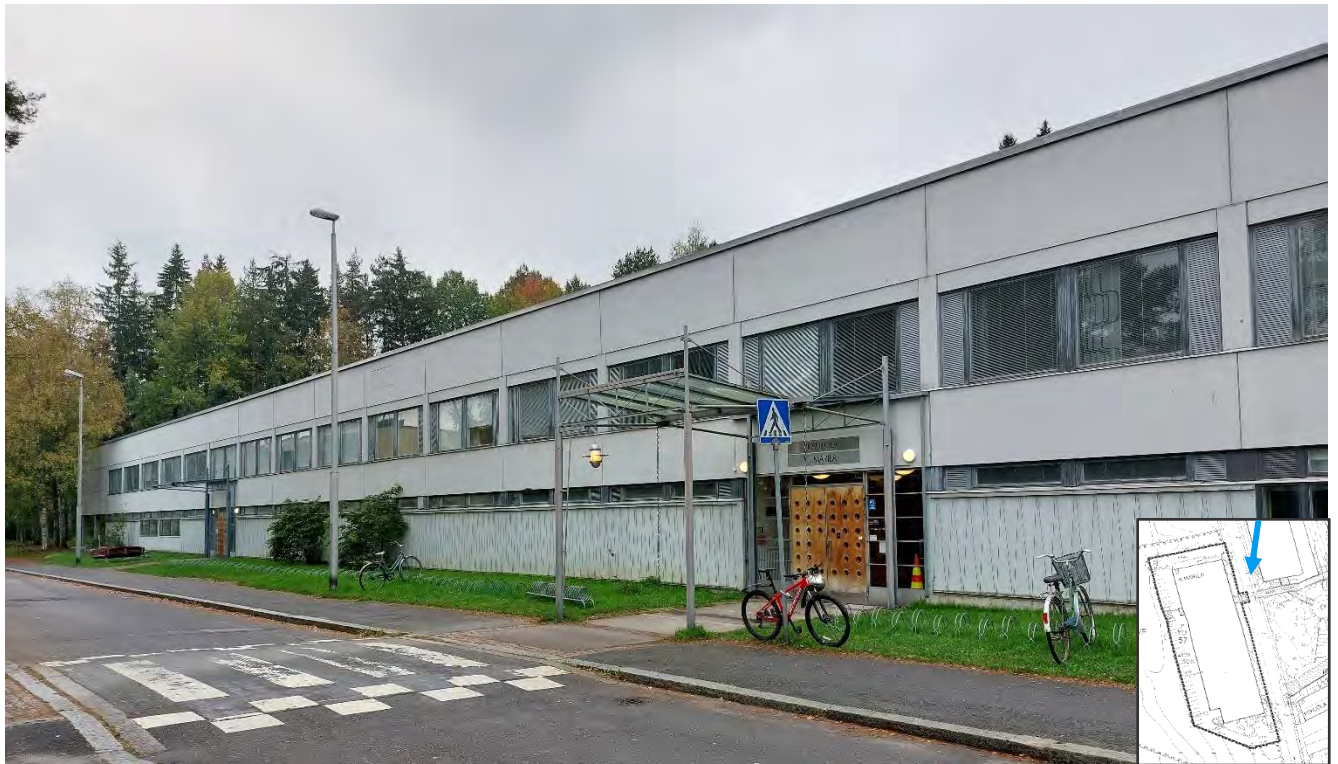
Kuva 134. Katujulkisivu on Ilmarilan näyttäväin julkisivu.
