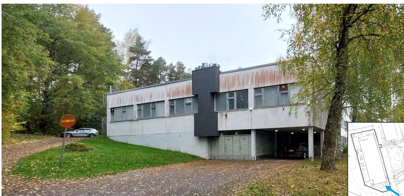
Kuva 136. Eteläjulkisivulla nähdään pohjakerroksen sisäänveto Rinnetien puoleisessa kulmassa. Sen viereiset puupaneloidut ovet ovat alun perin johtaneet kemikaalien varastointitiloihin.
