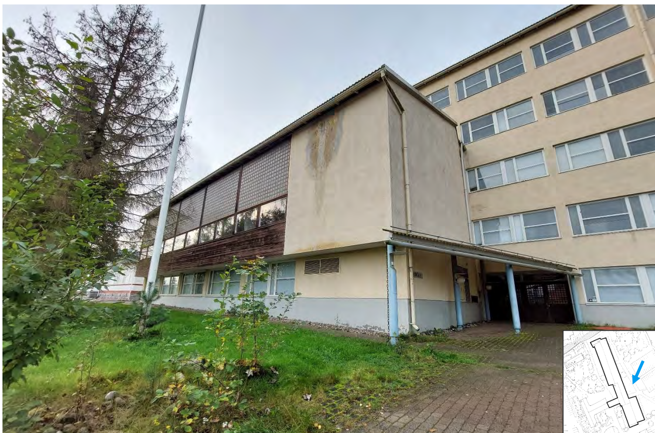
Kuva 35. Ainolan ensimmäisen kerroksen pääsisäänkäynti on kulmauksessa, vinon katoksen suojassa. Juhlasalin rappausjulkisivussa on vaurio.
