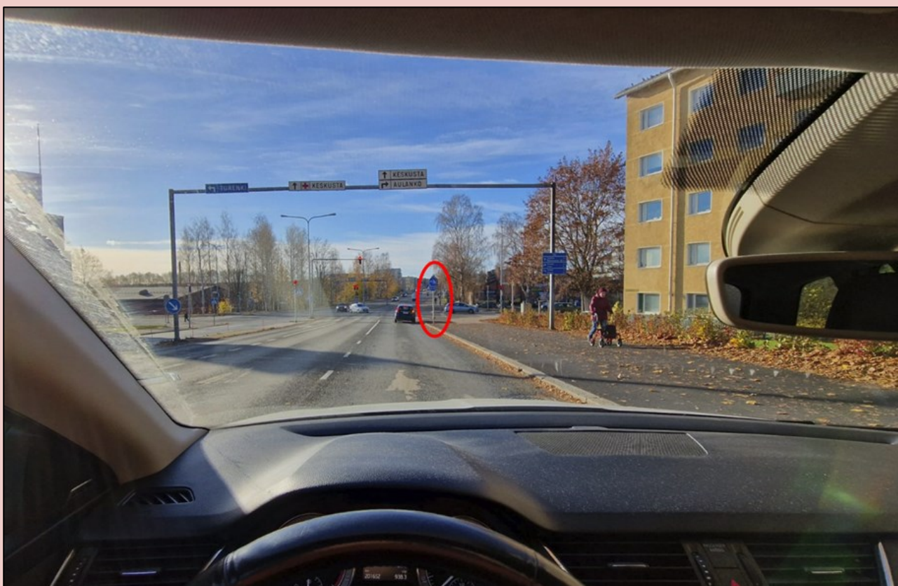
Kuva 19 Liikennemerkki peittää liikennevalojen pääopastimen kokonaan.
